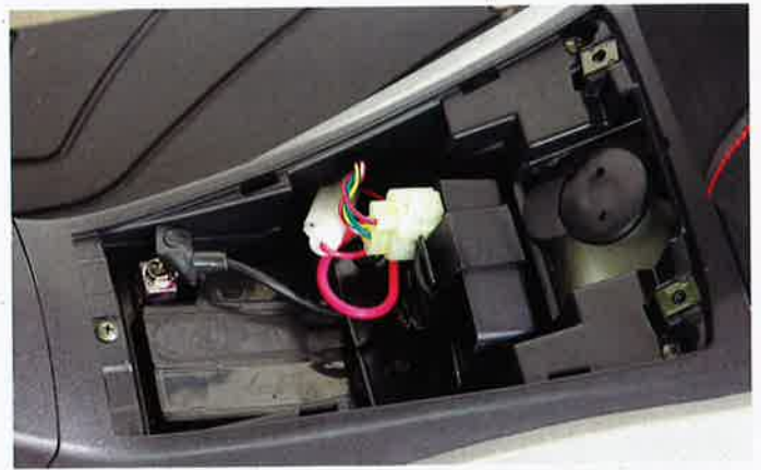
Akku, Motorsteuerung und Öltankstutzen im Mittelunnel
